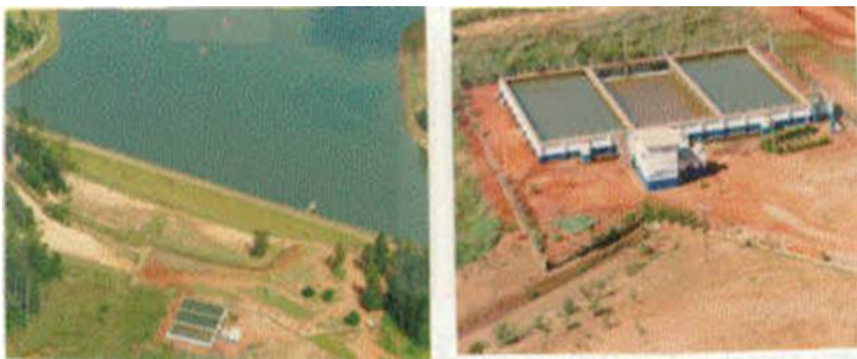
Figura 4.1 – Fotos do Manancial e de Filtros Lentos de uma Estação (Q = 150 L/s).
