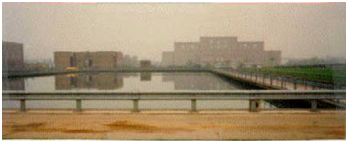
Figura 4.3 – Foto de um Filtro Lento da ETA Ashford Common (Londres-Inglaterra)
