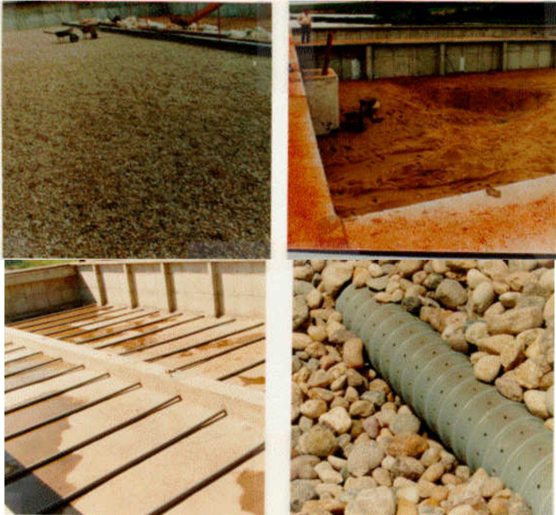
Figura 4.24 – Fotos ilustrando os drenos especiais, a colocação da camada de pedregulho e a de areia em um filtro lento
